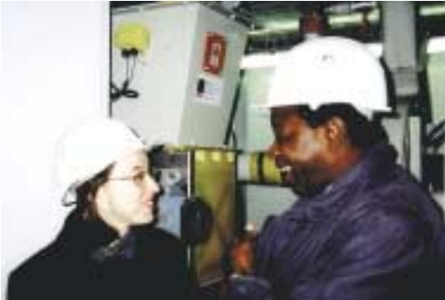
Lydie Ferrière, ingénieure, et M. Mignondo, vice-président du SIETREM lors de la réception des travaux de filtration des fumées.
